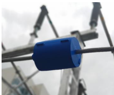
Рис.2. Датчик мониторинга образования гололёда
