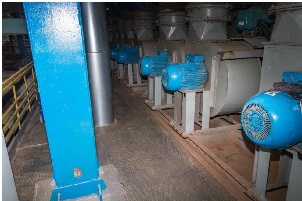
Рисунок 2.23 - Дутьевые вентиляторы Ц-13-50
