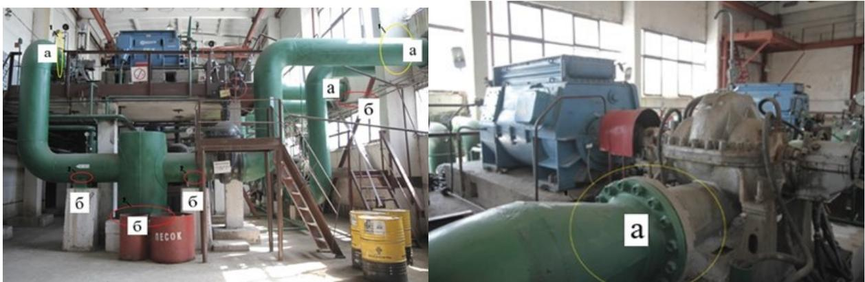
Рисунок 3.24 - Рекомендуемые места установок виброизолирующих вставок в цехе сетевой воды:
