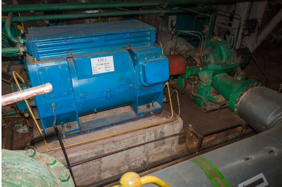
Рисунок 2.15 – Сетевой насос СЭ-2500-180-10 и электродвигатель, РК «Азино»
