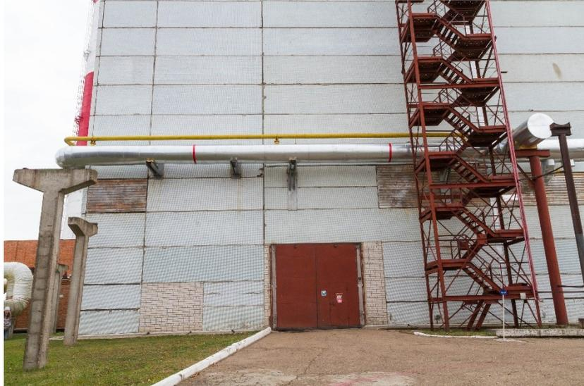
Рисунок 4.6 – Газопровод котельной.
