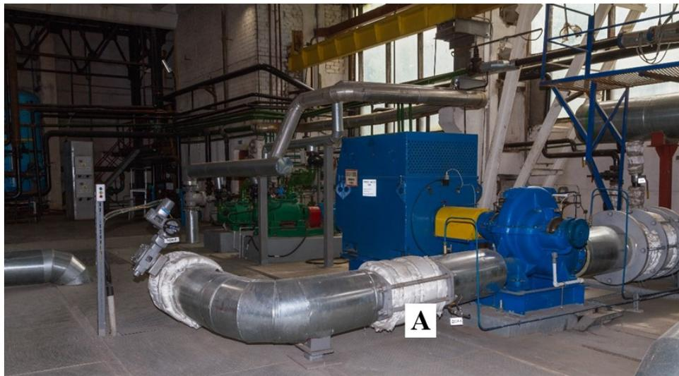
Рисунок 2.13 - Водяной насос КРВ6015-1/2 с электроприводом 500 кВт РК «Горки», А - компенсатор
