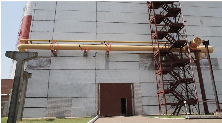
**Рисунок 3.25 – Рекомендуемые места установок виброизолирующих прокладок для наружной газовой трубы**
