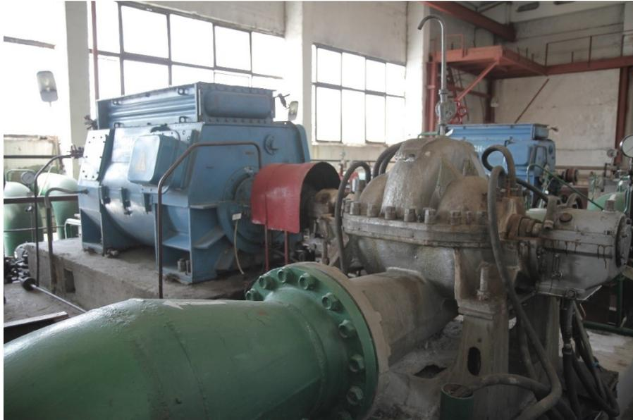
Рисунок 2.4 - Сетевой насос СЭ-2500-180 с электроприводом 4А3М-1600/6000 УХЛ4 (РК «Савиново»)
