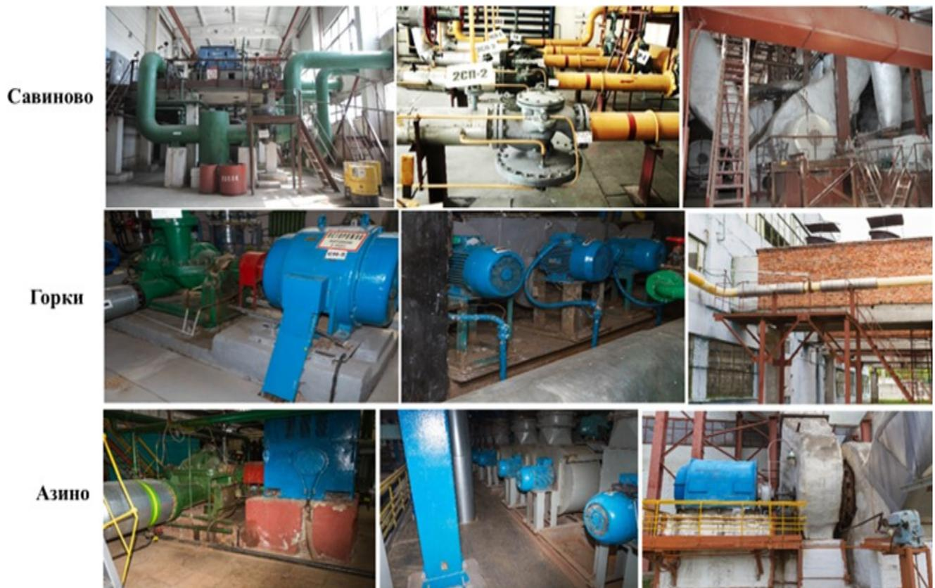
б) Отсутствие виброизолирующих вставок (компенсаторов), виброизолирующих прокладок.
