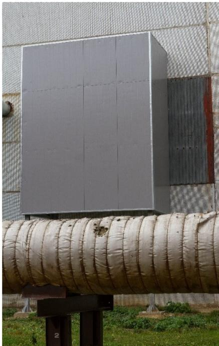
Рисунок 4.7 – Воздухозабор дутьевого вентилятора
