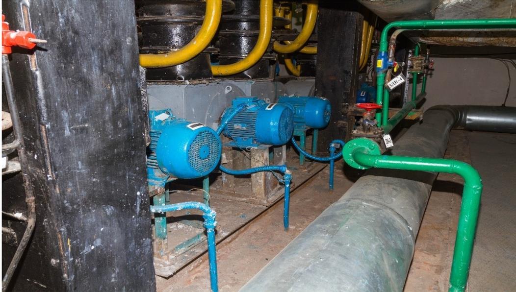
Рисунок 2.25 - Дутьевые вентиляторы ВЦ-14-46№4
