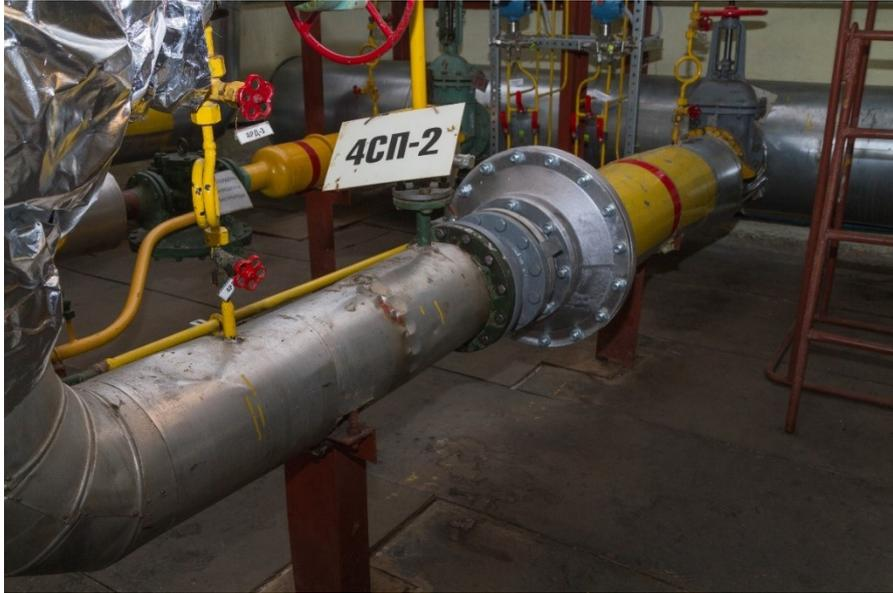
Рисунок 4.2 – Газовый редуктор РДП-200ВЛГ
