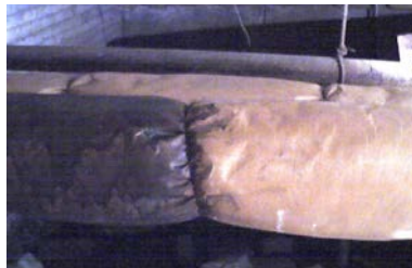
Рис. 4.1. Поверхность теплоизолированного участка трубопровода тепловой сети с нанесенным ТПП и без него
